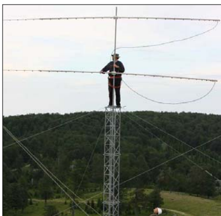
Slika 8. Montaža antena za 432MHz
