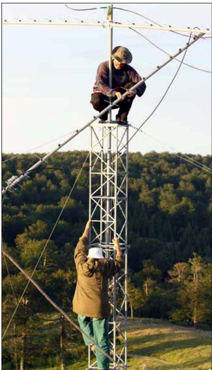
Slika 7. YU1CF i YU1KX montiraju stub za 432MHz
