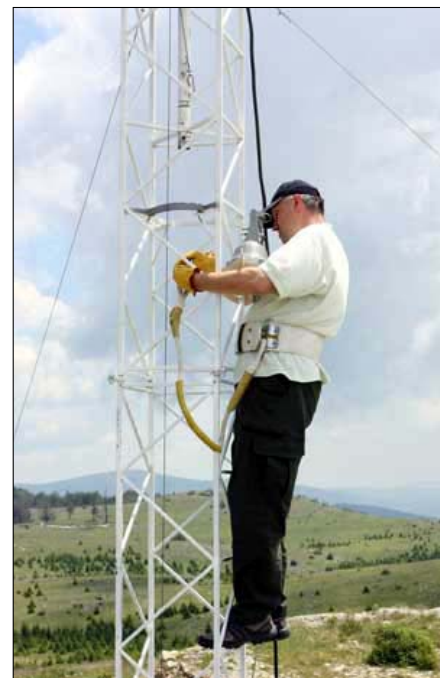
Slika 10. Srđan YT2KUM prilikom montaže HAM III rotatora
