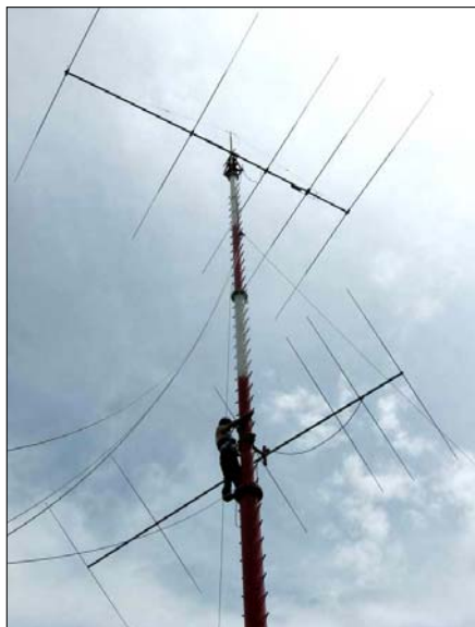
Slika 1. Gledajući "odozdo" deluje da ova 50MHz 6el antena i nije mnogo manja od 5el za 21MHz
