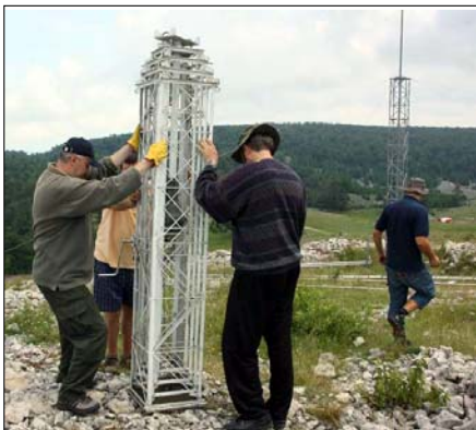
Slika 6. Postavljanje teleskopskog stuba za 144MHz
